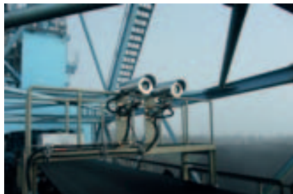
Тепловизионные камеры FLIR в защитном корпусе, установленные над ленточными транспортерами для подачи угля
