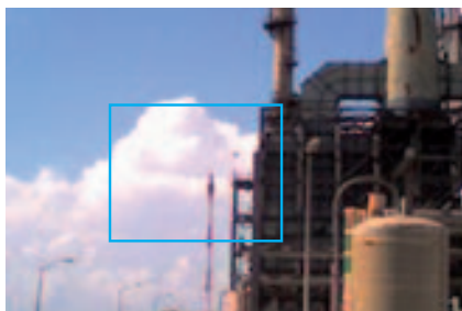
Практически невидимая невооруженным глазом, тепловизионная камера позволяет контролировать горение факела
