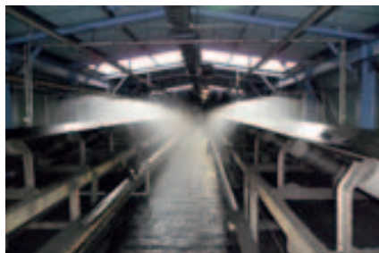
ПЛК немедленно останавливает ленточный транспортер и включает спринклерную систему пожаротушения при срабатывании теплового пожарного извещателя
