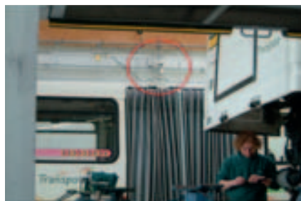
Тепловизионные камеры FLIR осуществляют непрерывный контроль всех помещений
