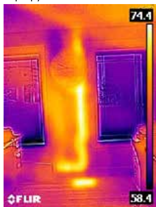
Теплая сливная труба в стене
